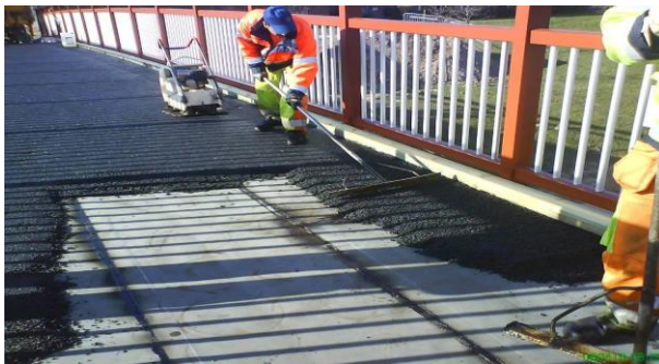
Kuva 27. Vesieristykseen päälle tehdään monikerroksinen yhteensä (110 mm paksuus) asfalttinen kulutuskerros. [1].
