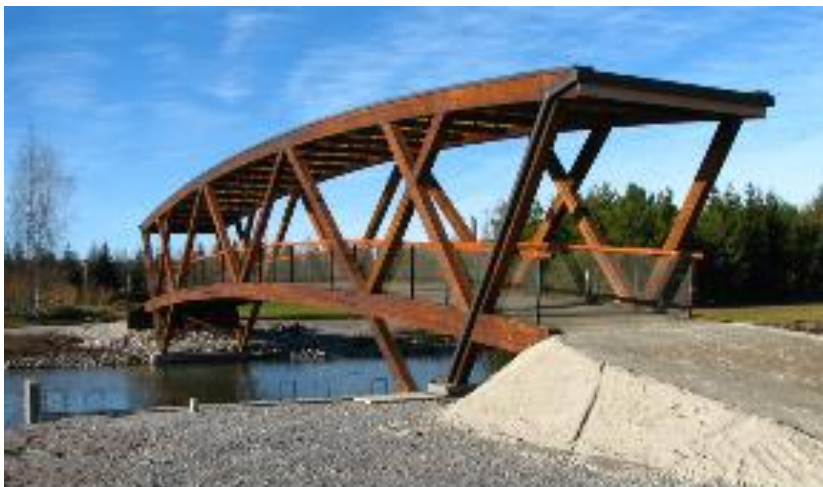
Kuva 19. Katettu silta (Suntinrannan silta, Parainen) [8].
