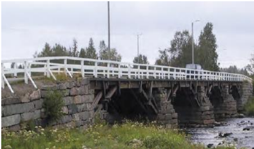
Kuva 18. Tukiansassilta (Eteläjoen Isosilta, Pyhäjoki, v. 1837) [8].
