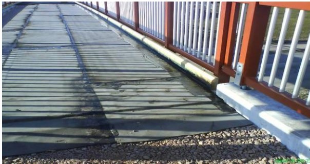
Kuva 26. Kannen päälle tehdään vesieristys [1].
